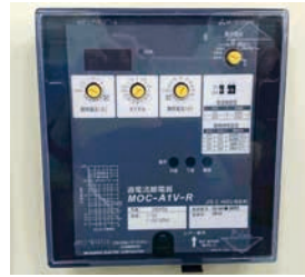
過電流継電器(静止型)
