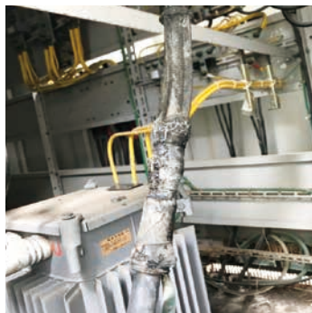
漏れ電流により焼損した高圧ケーブル
