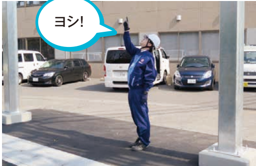
構内柱の点検 目視で柱上の機器の状態を確認
