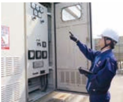
外観点検・各計測メーターの指示値を確認
