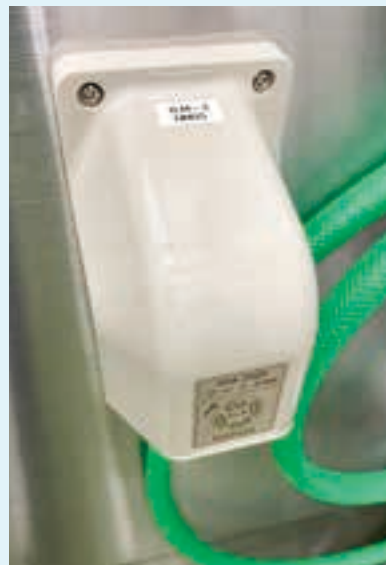
取替後のコンセント
