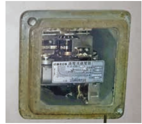
過電流継電器(誘導型)
