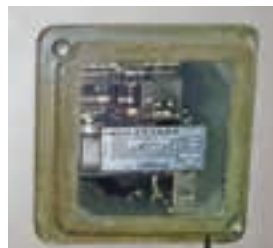
過電流継電器(誘導型)
