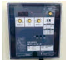
過電流継電器(静置型)
