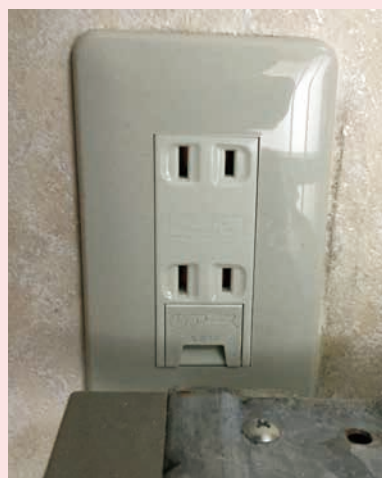
交換したコンセント
