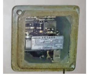
過電流継電器(誘導型)
