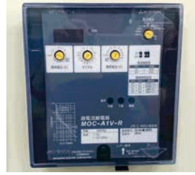
過電流継電器(静止型)
