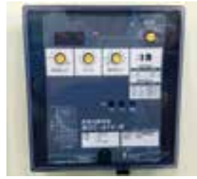
過電流継電器(静止型)
