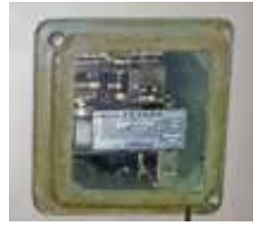
過電流継電器(誘導型)
