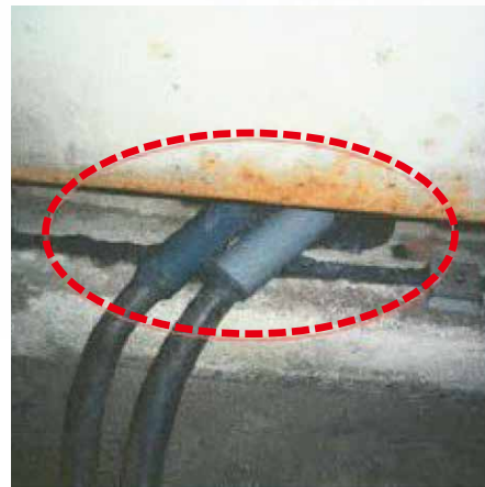
小動物の侵入対策部
