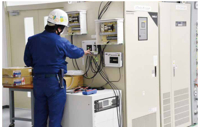
総合技術センターのPCSが本店からの遠隔操作により運転・停止していることを確認
