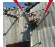
高圧変圧器 高圧コンデンサー
