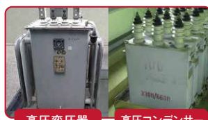
高圧変圧器 高圧コンデンサー
