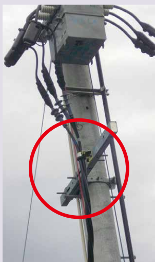
改修後、腕金を下げてケーブルを固定した
