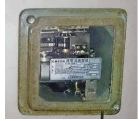
過電流継電器(誘導型)
