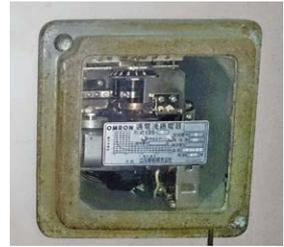
過電流継電器(誘導型)
