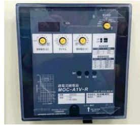
過電流継電器(静止型)
