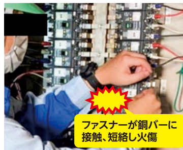
基礎工事中の分電盤作業
