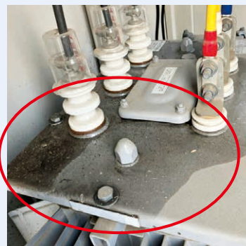
動力変圧器の上に漏油の痕跡を確認
