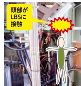
通信端末の設置工事
