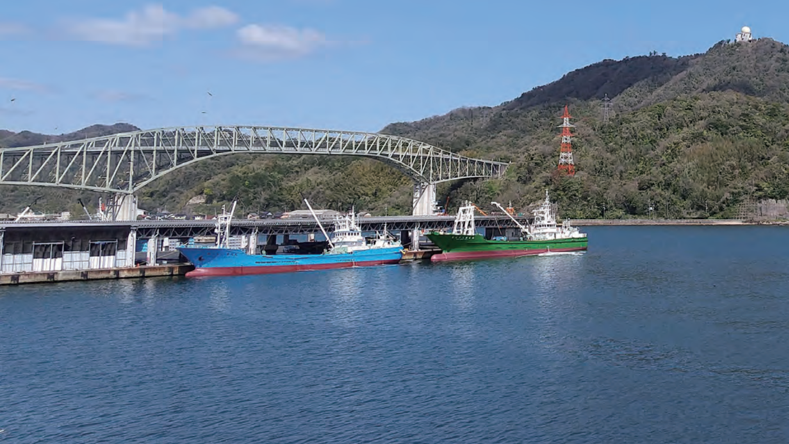
境港市 境水道大橋
