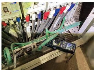
漏洩電流の数値から、電線が焼損し火災につながる恐れや、感電などの大事故に繋がる恐れがあるため、早急な解決が必要と判断しました。
