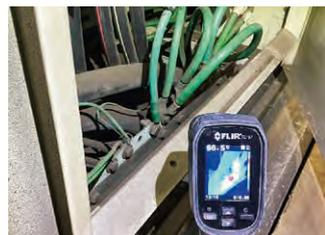
漏電の原因となった箇所は、建屋側面の高所に設置されていた門型クレーンのトロリー線の中継部のカバーでした。
