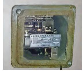
過電流継電器(誘導型)
