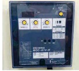
過電流継電器(静止型)
